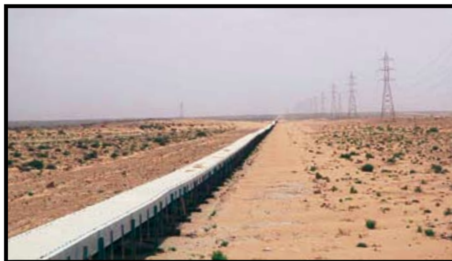
Det marokkanske transportbåndet for fosfat fra det okkuperte Vest-Sahara er over 100 km langt og dermed verdens lengste.
